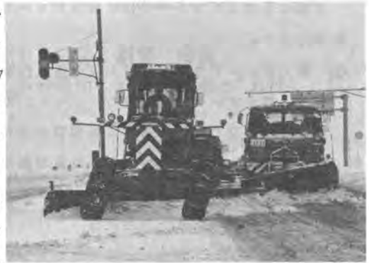
写真-5 除雪作業状況
