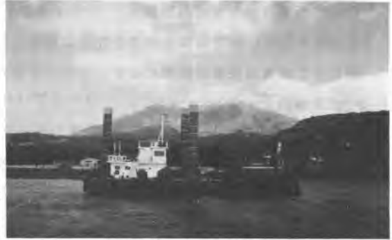
写真—2 土石処理船全景
