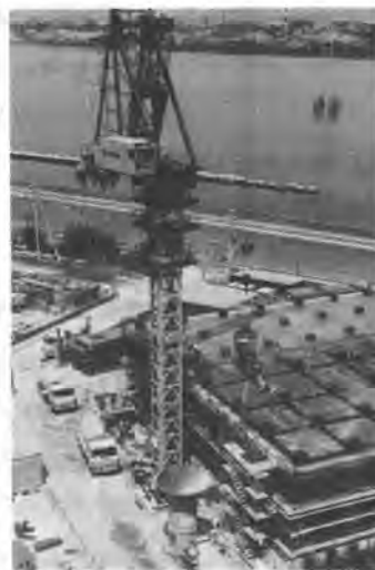
写真1 メカトロ高速タワークレーンによる RC超高層ビル自動化施工システム
