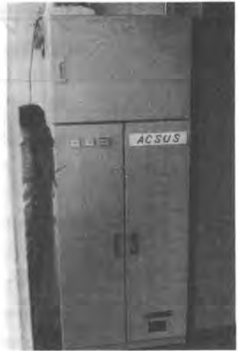
写真2 運転室内コントローラ設置状況
