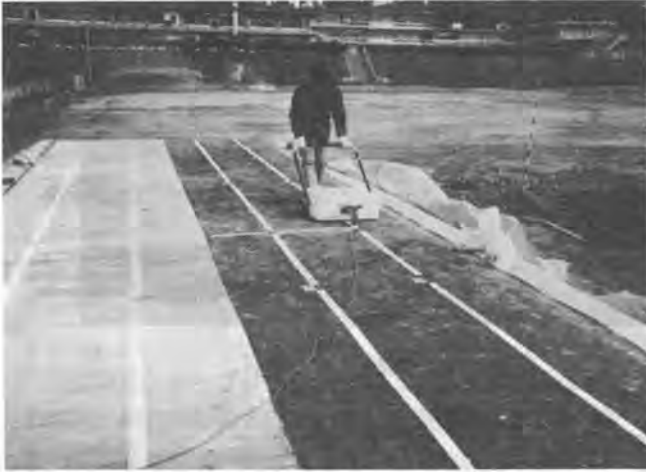
写真-2 探查試験中の地中レーダ
