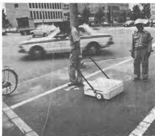
写真-3 現地探査試験
