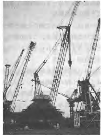
写真-1 タワークレーン設置状況
