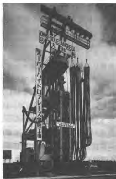
写真-1 スーパーハイドロフレイズ掘削機
