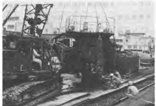
写真-1 ホームに列車が入ってくるため一時的に本体を撤去
