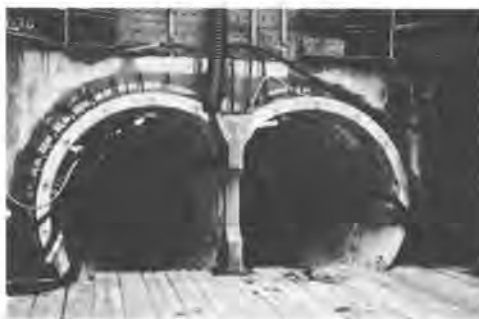
写真-2 施工完了全景
