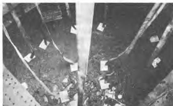
写真-5 ドレン材の鉛直性確認 (深度3m)
