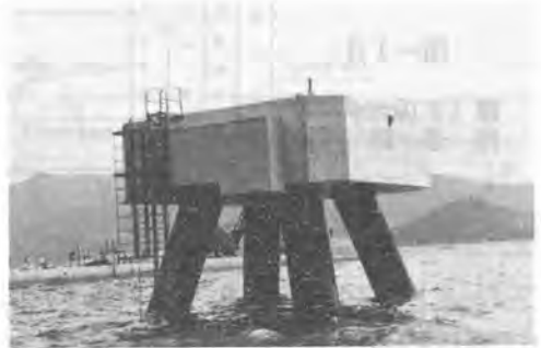
写真-1. 完成した海上アンカー
