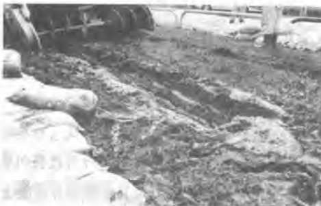
写真-5 同装置が「めり込む」状況等の問題点が判明したため「改造」を実施した。
