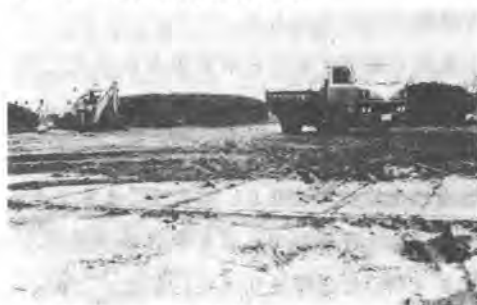
写真-2 機械施工による処理作業
