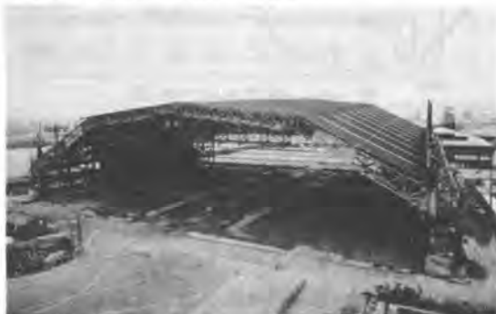
写真-1 リフトアップ後のHANGAR
