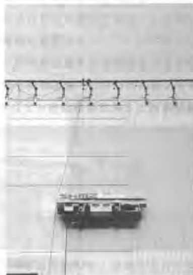
写真-1 外壁自動吹付け装置
