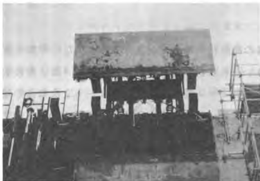
回転上昇中の自動式型枠(写真-2)
