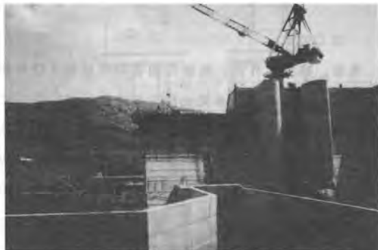
順調に稼動中の3基の自動式型枠(写真-3)
