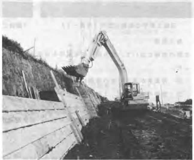
写真-1. 作業状況
