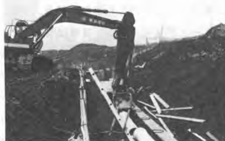
写真-4. ヒュム管敷設状況
