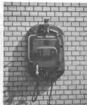
写真-5 外壁タイル剝離 調査ロボット
