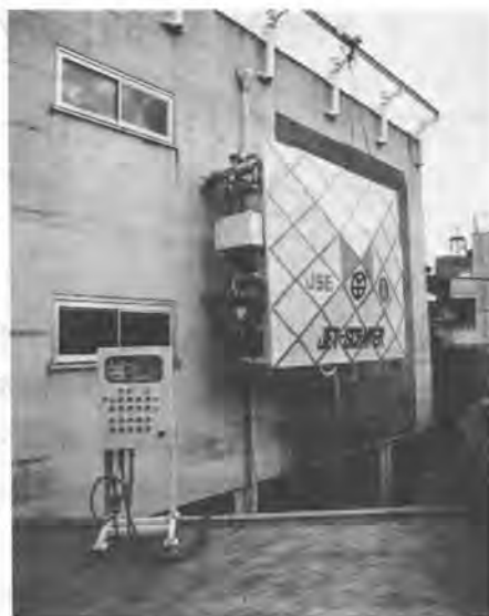
写真-6 外壁塗膜剝離ロボット "ジェットスクレーバ"
