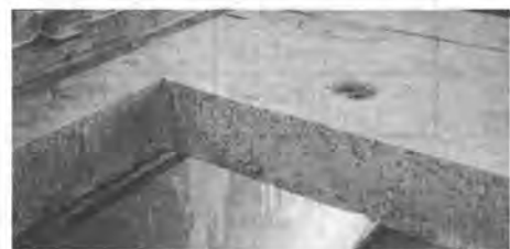
写真-3. 同上切断面
