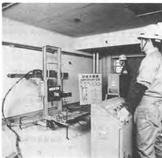
写真-1. 仙台宮城野団地壁切断
