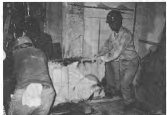
写真4 ブロック搬出状況
