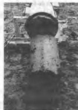
写真-1 土砂搬出状況
