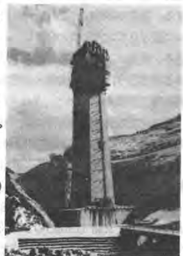
写真-1 阿木川大橋施工状況
