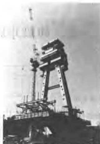
写真-2 志摩丸山橋施工状況
