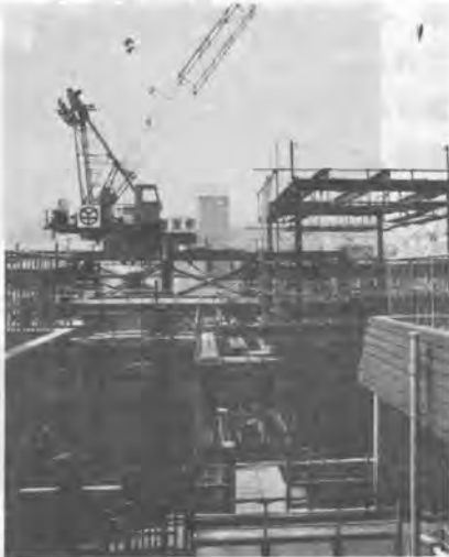
写真-5 トラベリング前の状況
