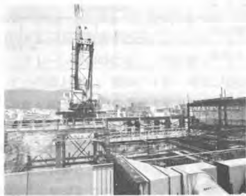
写真-6 トラベリング後の状況
