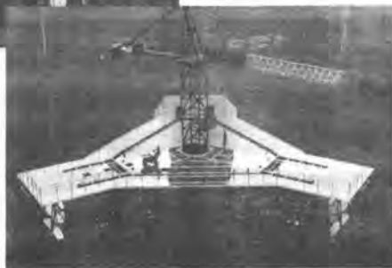
写真-2 スリップフォーム構造概要
