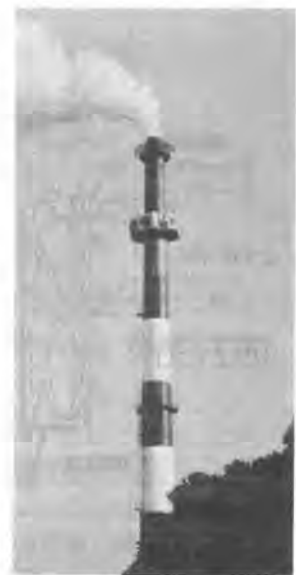
写真-6 補強工事状況
