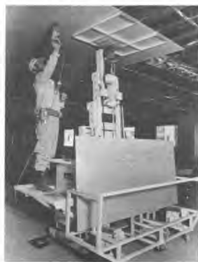
写真2 CFR-1による施工状況
