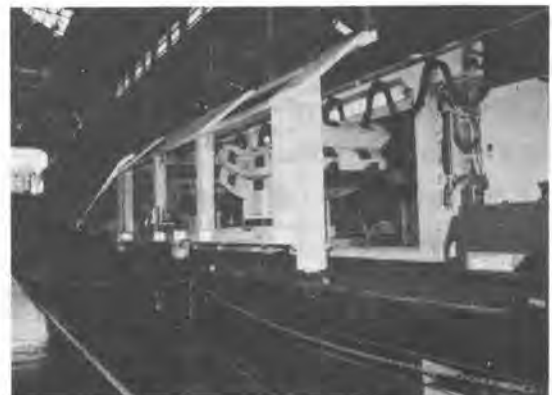
写真-2 セグメント供給装置
