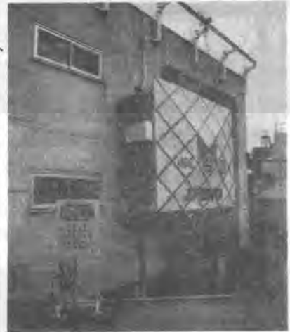
写真-1 外装塗膜自動剝離機
