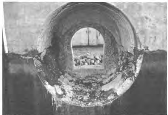
写真-3 掘削後の状況
