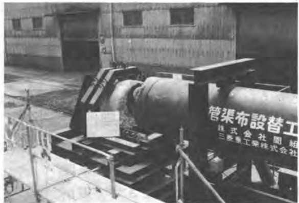
写真-2 掘削中の状況
