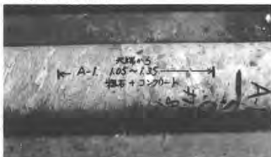
写真-2 粗石コンクリートのコア
