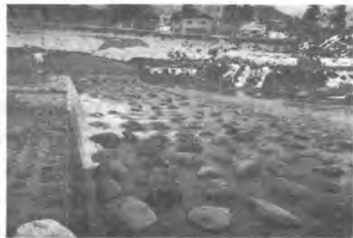
写真-4 粗石護床工施工状況（山形県馬見ヶ崎川）
