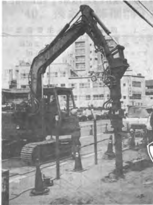
写真-2 狭あい部締固め装置（垂直転圧板接続）
