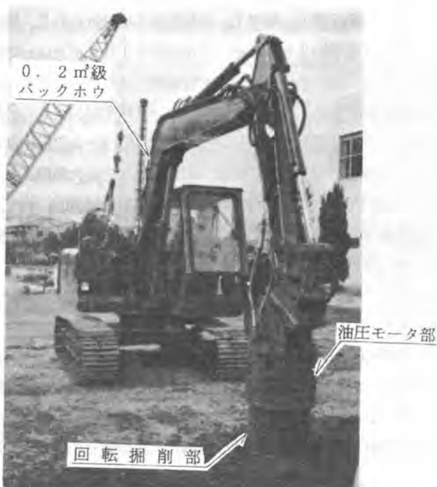
写真-1 狭あい部掘削装置（回転バケット）
