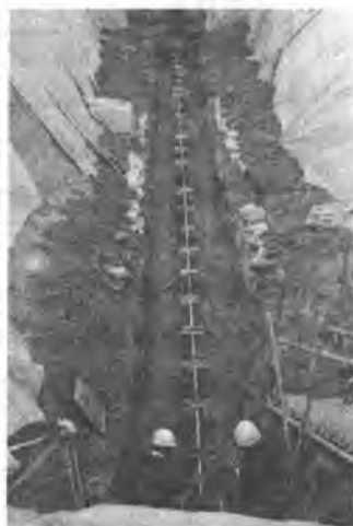
写真 鋼杭打設完了状況
