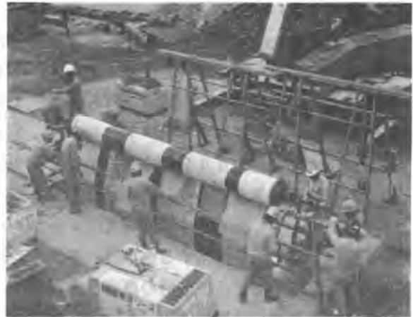
写真-2 遮水シート挿入状況
