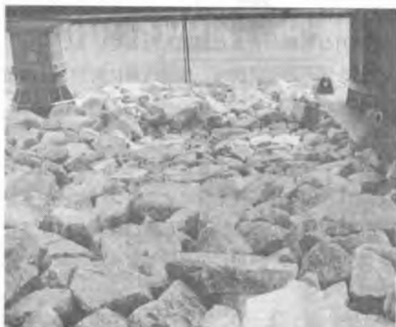
写真-3 均し後の状況（陸上実験）
