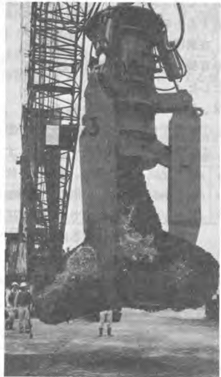
写真-2 テトラポッド陸揚げ
