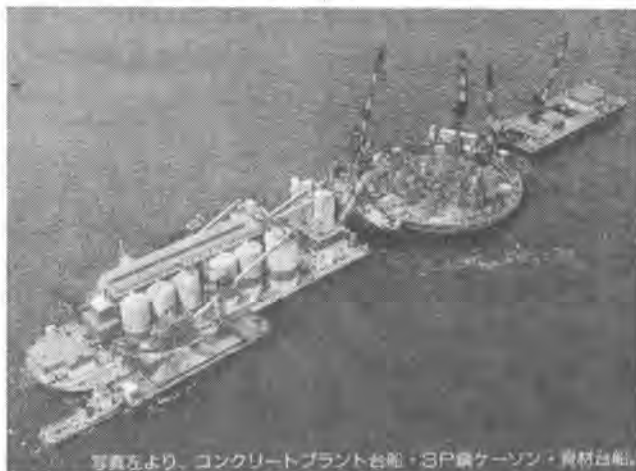
写真-1 「海神」によるコンクリートの打設風景
