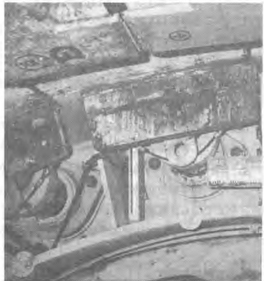
写真4 シールドマシン制御
