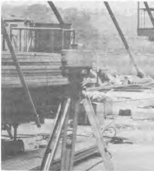
写真3 斜張橋のレベル管理
