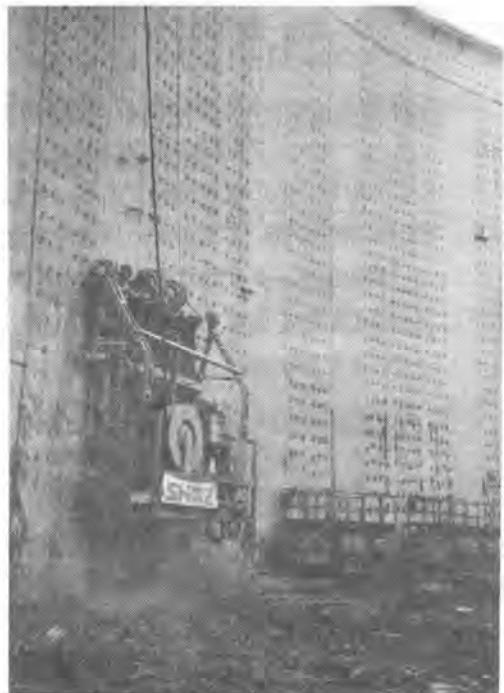
写真-2 稼働中の懸垂式自動壁面目荒し機
