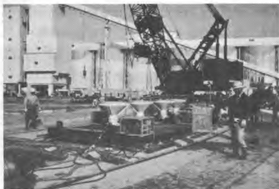
写真-1 現場据付状況
