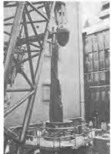
写真-2 シートパイルの引抜き
