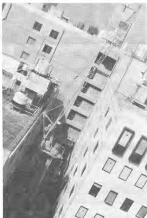
写真-1. 従来型クレーンの設置事例
