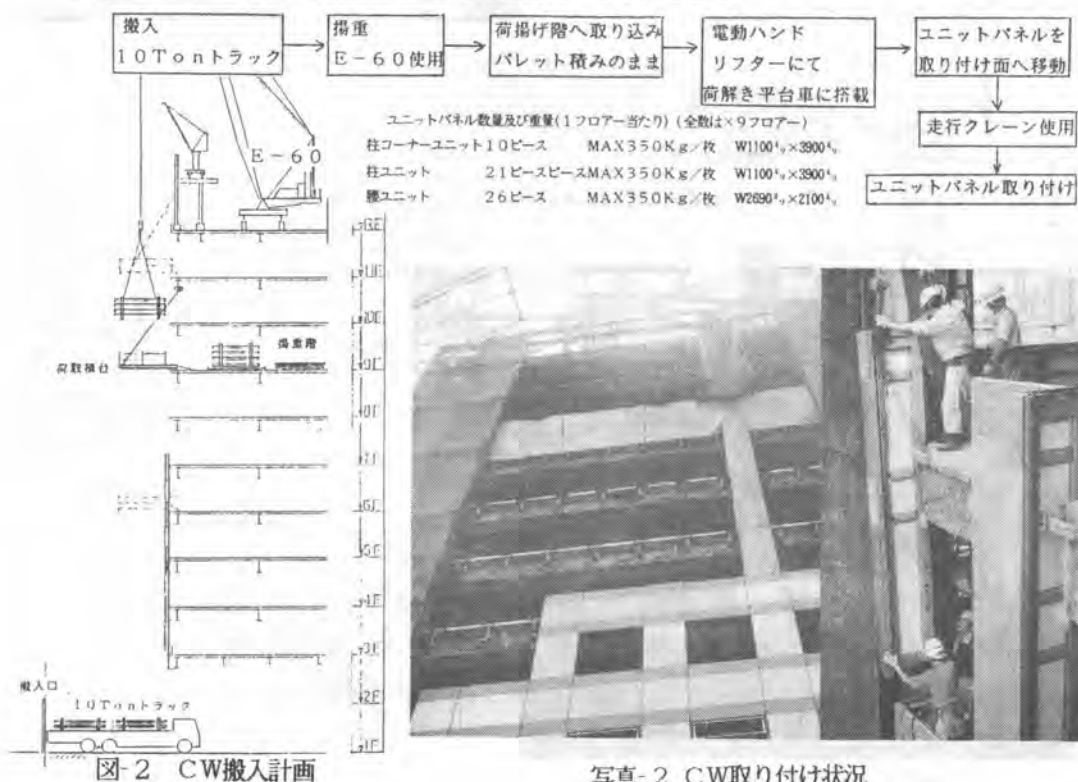
写真-2 CW取り付け状況
