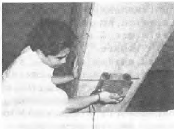
図-6 梁の探査状況
