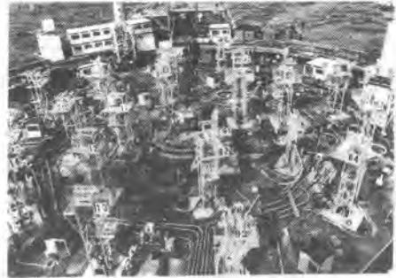
写真-2 ケーソン上の打設設備 (コンクリート配管(φ200), 分岐弁, 打設管引上装置等)
