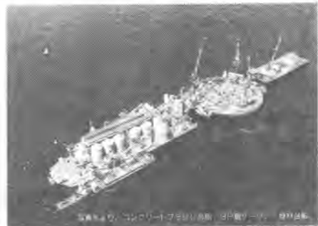
写真-1 C P船「海神」によるコンクリート打設状況
