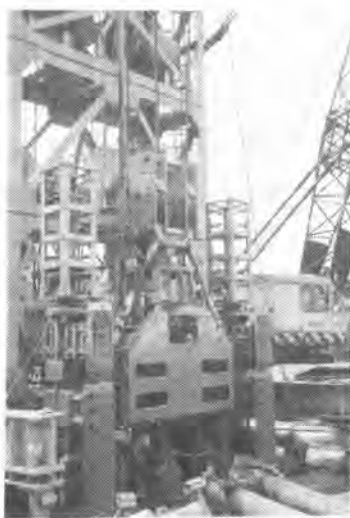
写真2 センサ筒取付状況
