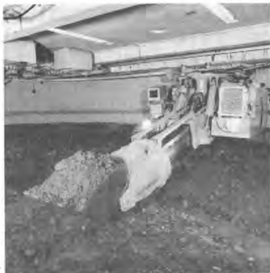
写真-1 稼働中の掘削機
