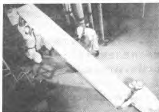
写真-1 パネル取付作業
