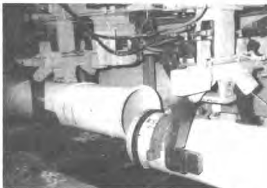
写真-3 送泥管端面の自動芯出し
