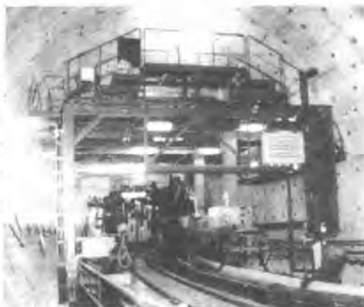
写真-1 送排泥管延長ロボット
