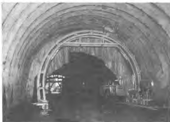
写真-2 吹付装置
