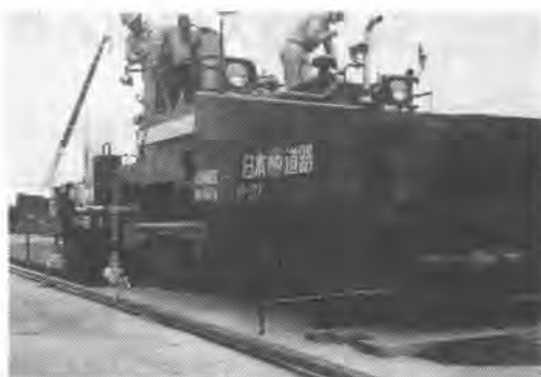
図5 敷き均し状況
