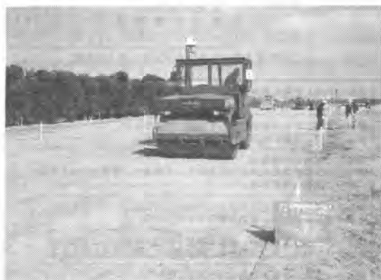
写真-1 オシレートリローラによるダートコース転圧状況
