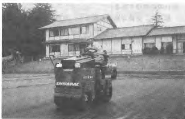
写真-3 LA75の舗装転圧状況
