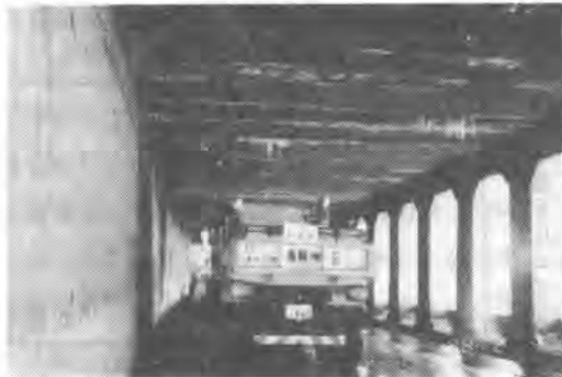
写真-1 人力によるツララ処理作業
